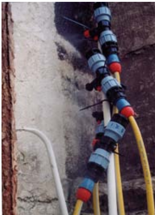
249-250. Prospetto nord: prove di pulitura con impianto di acqua nebulizzata
