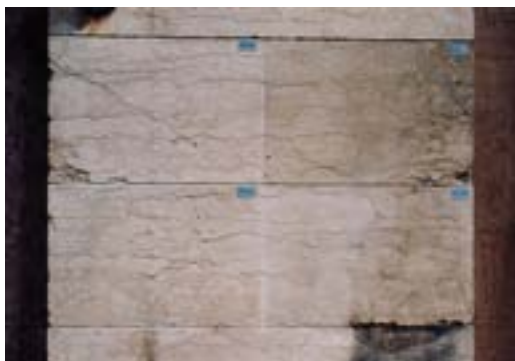
257. Prospetto sud: area campione selezionata sul cornicione cinquecentesco per valutare la pulitura ad impacco con soluzioni basiche ed il successivo trattamento protettivo della pietra con tre prodotti diversificati
